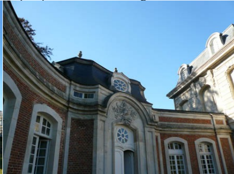
La galerie sud du château
